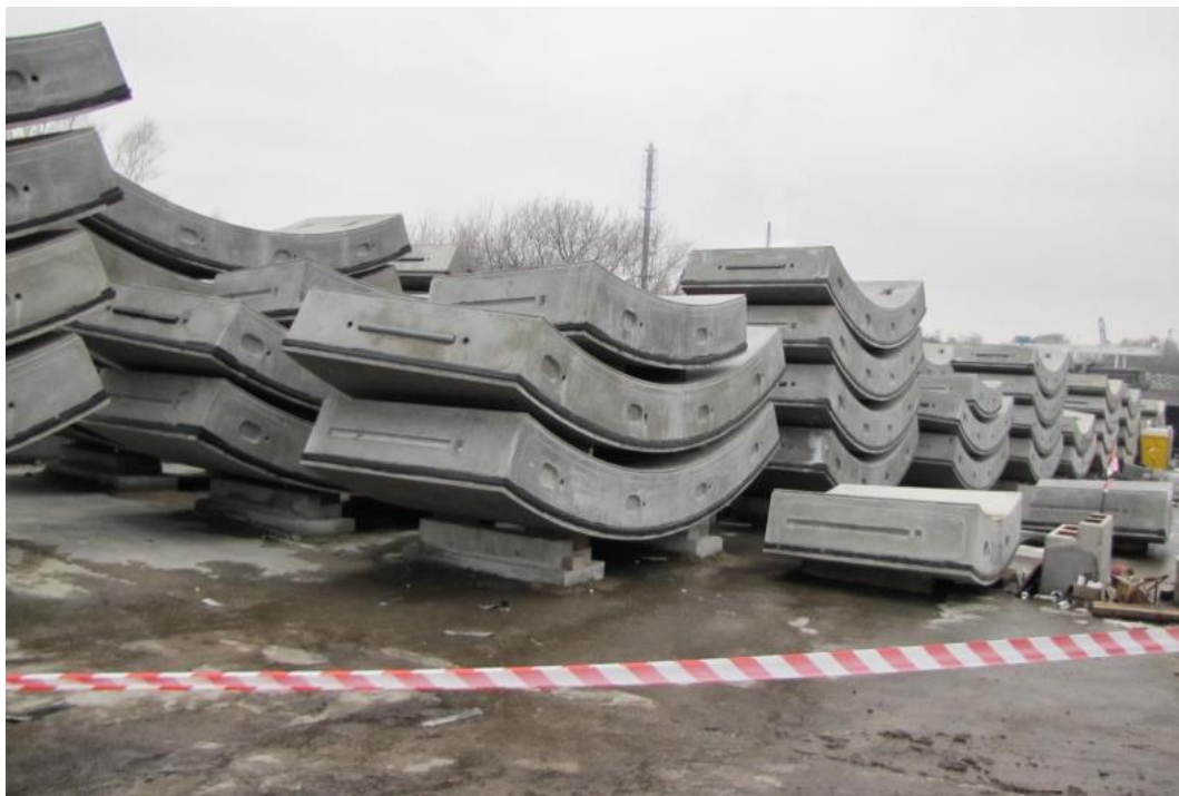
Tubingi stanowiące obudowę przeprawy tunelowej
