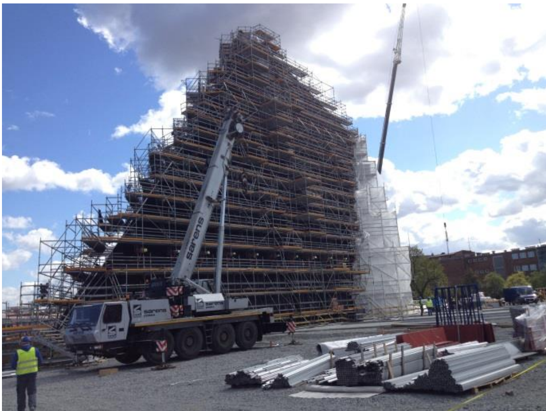
Budowa siedziby Muzeum
